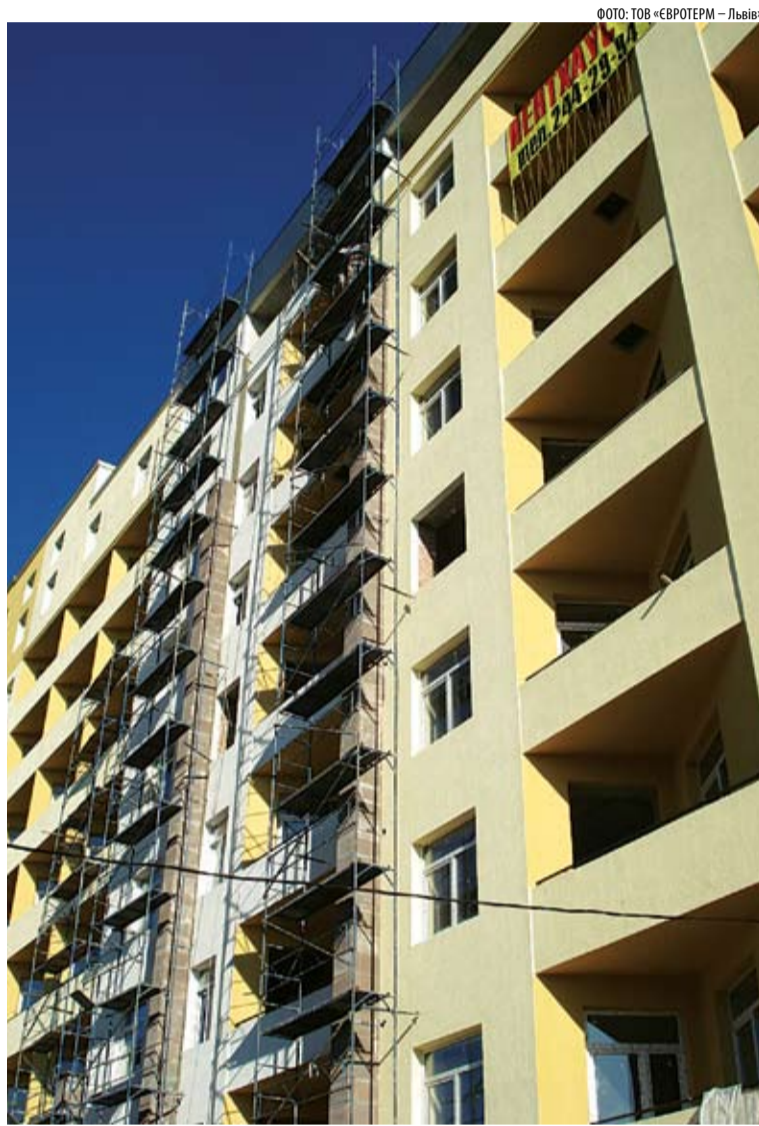
Приклад монтажу димохідної системи на фасаді (варіант, коли можна зекономити площу квартири). Після закінчення монтажних робіт димохідну систему декорують у відповідності з архітектурним рішенням будинку
